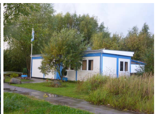
Container der Straßensozialarbeit
