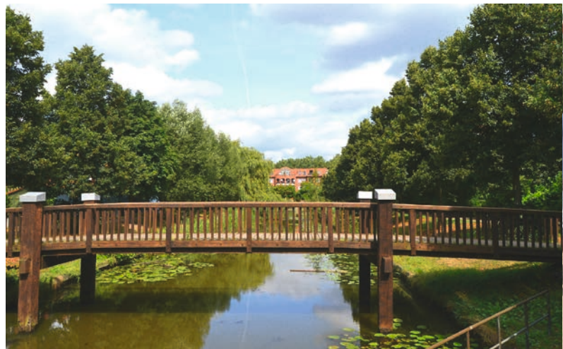
Eine der 76 Brücken Neuallermöhes
