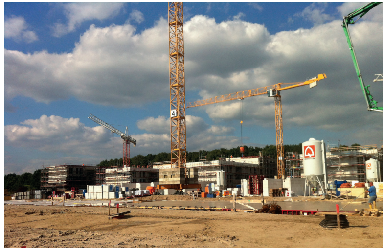
1. Bauabschnitt - Baufortschritt September 2016
